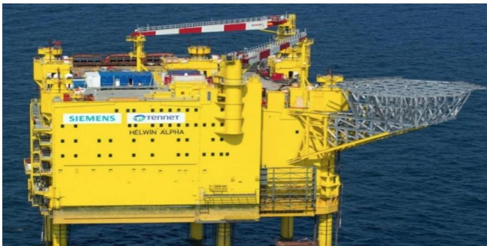
La plate-forme de transformation peut être un élément très lourd, (on voit ici une plate-forme de 500 MW qui pèse quand même 12 000 tonnes), et il faut signaler que pour exporter une grande puissance à une grande distance par des câbles électriques sous-marins, cela pourrait ne pas être très efficace si la puissance est trop grande et les distances très importantes.
