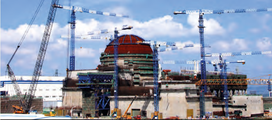
Chantier du Hualong de CNNC/Huadian sur le site de Fuqing, dont la connexion au réseau est prévue pour 2020
