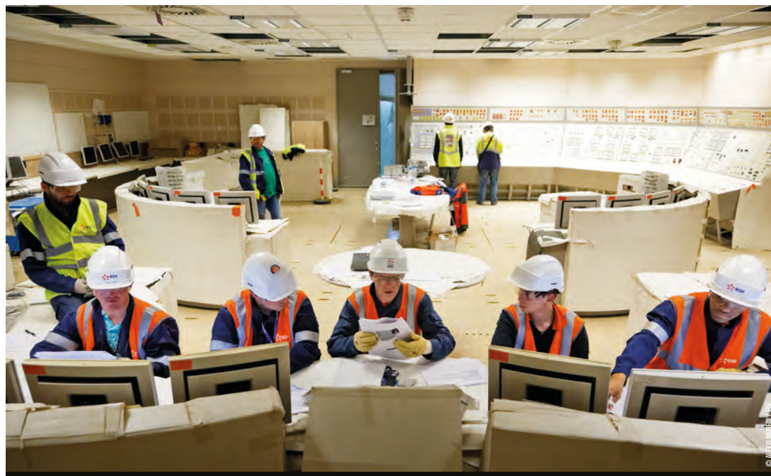
Bâtiment de sauvegarde de l'EPR : les futurs exploitants se forment à la prise en main de la salle de commande
