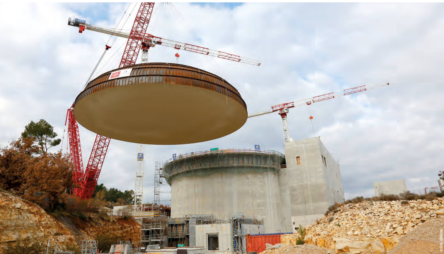
La pose du dôme (150 tonnes) a été réalisée en une fois
