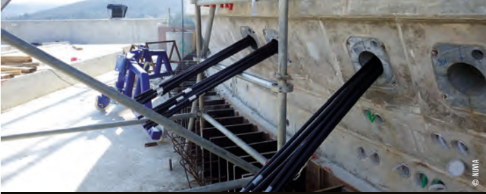
La technologie de précontrainte par torons gainés graissés
